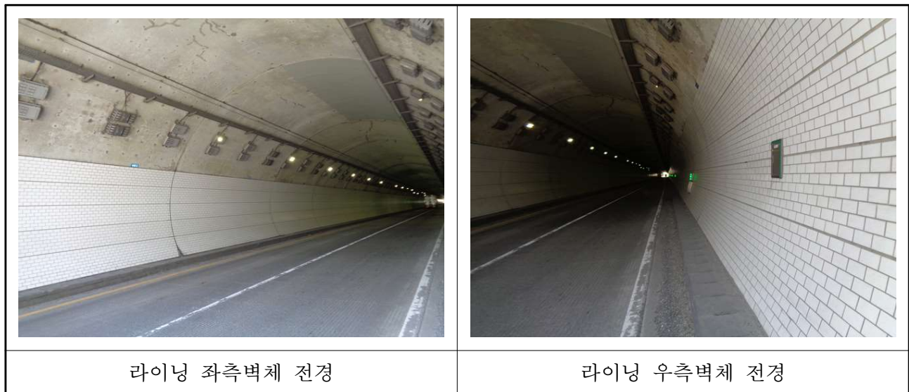
【사진 3.5】 터널 라이닝 측벽부 전경
