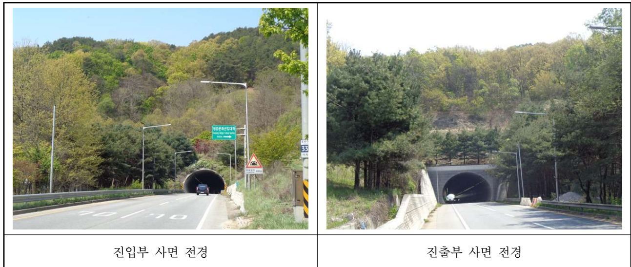
【사진 3.9】 사면 진·출입부 전경
