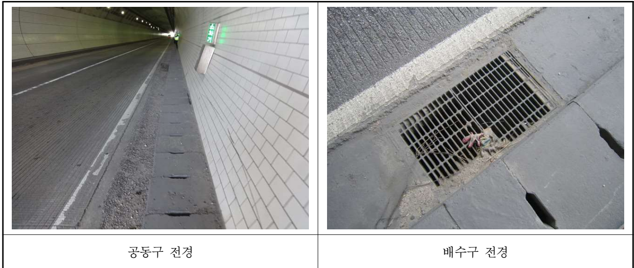
【사진 3.11】 공동구 및 측구(배수로) 전경
