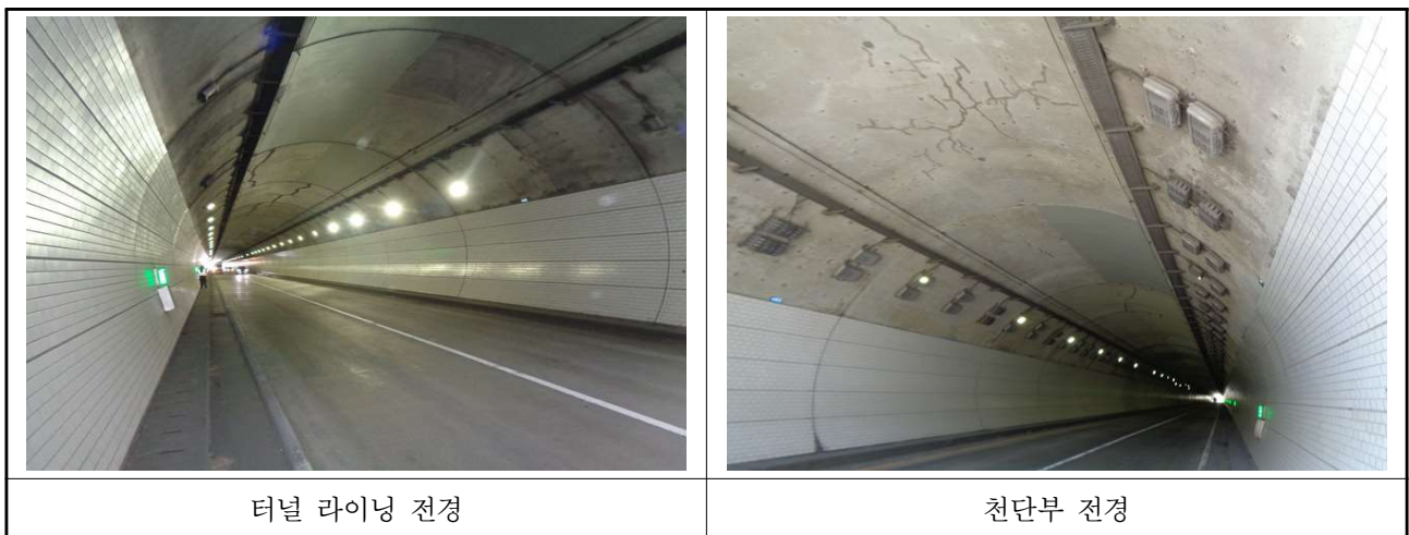
【사진 3.3】 터널 라이닝 천단부 전경
